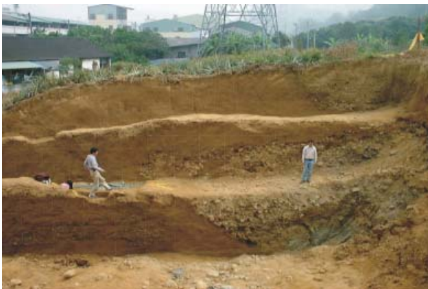
圖十 在霧峰地區的槽溝開挖
