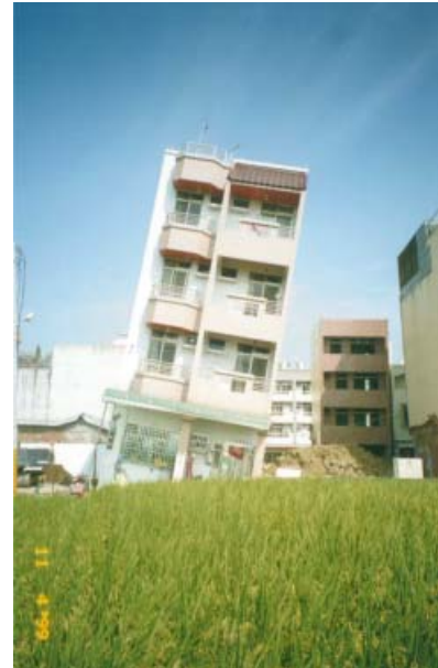
照片三 台中縣霧峰鄉四德路建物傾斜情形
