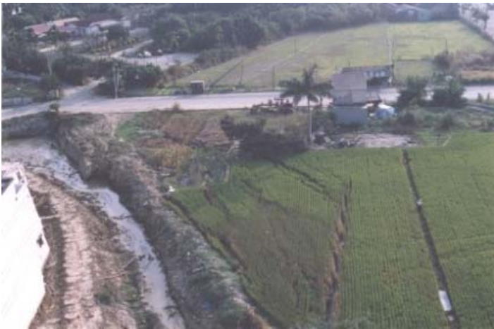
照片四 土壤液化引致之地盤側移
