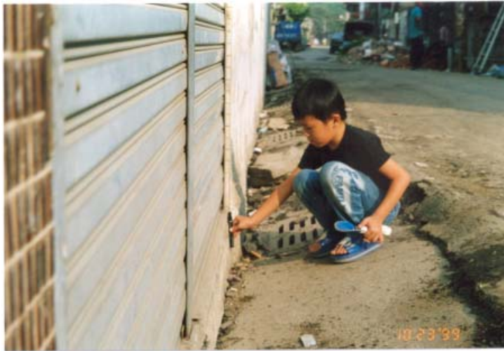
照片二 台中縣太平市因土壤液化引致之地盤沈陷
