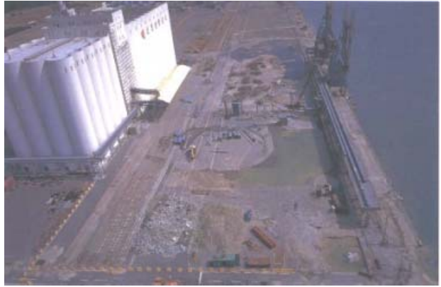
照片七 集集地震台中港1-4A沈箱碼頭護岸之受損情形
